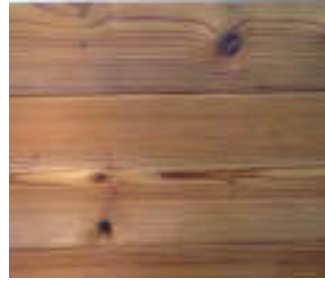
Thermofichte Blockwand geschliffen
