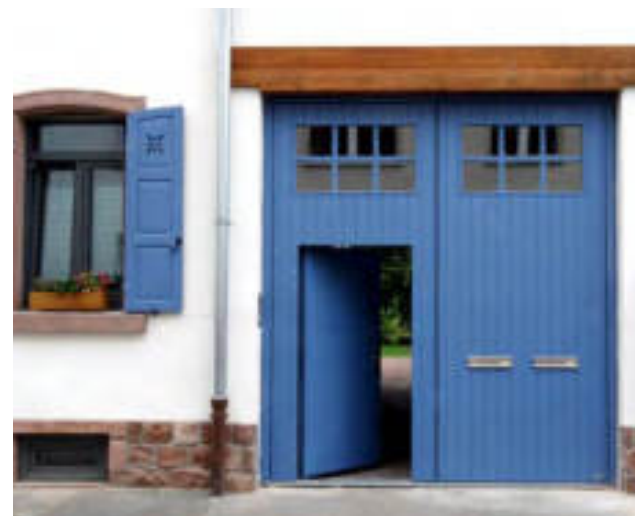
Flügeltor als Hoftor mit Durchstiegstür und Briefkastenausschnitten
