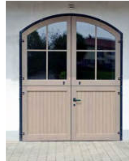
Flügeltor, lasiert in jutebraun mit waagrechter Teilung für Reithalle
