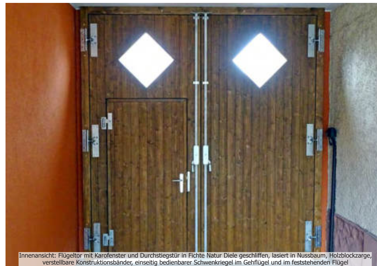
Innenansicht: Flügeltor in Fichte Natur Diele geschliffen, lasiert in Palisander, Holzblockzarge, Baskülverschluss mit Drücker Ronny (Langschild) im Gehflügel und Tortreibriegel im feststehenden Flügel
