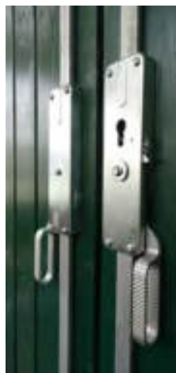
Innenansicht: links einseitig bedienbarer Schwenkriegel, rechts beidseitig bedienbarer Schwenkriegel
